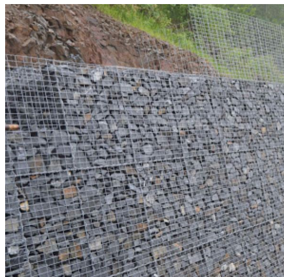
S2 - zajištění svahu gabionovým polštářem, primární využití místního kamene vytěženého při stavbě
