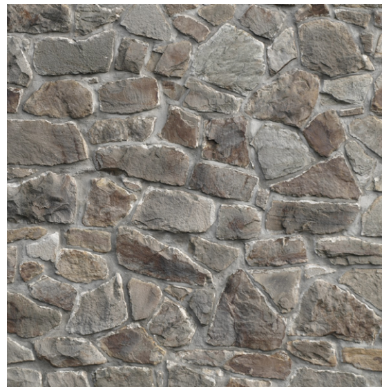
S1 - zárubní zdi kamenné, primární využití místního kamene vytěženého při stavbě
