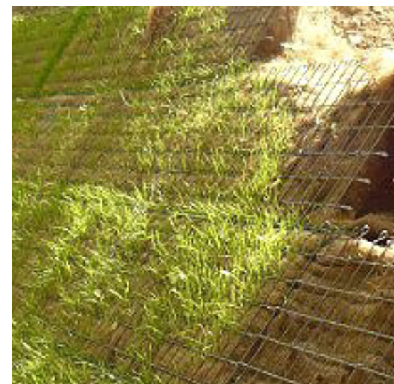
lokálně ve vhodných pozicích gabionový polštář doplněn vegetační vložkou
